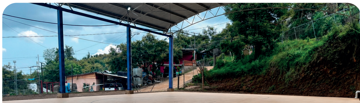
Rehabilitación de la explanada cívica en la escuela primaria de Agua Nueva. Esta obra benefició a 264 personas y tuvo una inversión de $518,321.14
