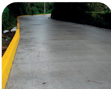
Construcción de pavimentación en El Pinabete, sobre el acceso principal. La obra benefició a 148 personas con una inversión de $1,086,520.29
