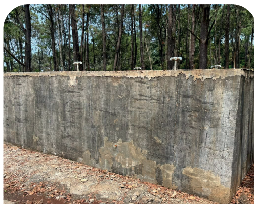
Construcción de depósito de agua en Enándiro. Benefició a 154 personas, con un monto de $615,788.93
