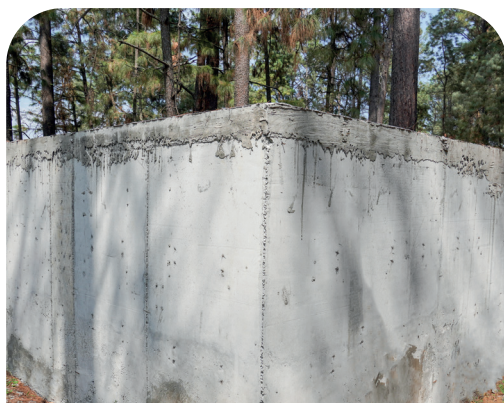
Construcción de depósito de agua potable en La Mora. La obra benefició a 105 personas y representó una inversión de $375,932.20
