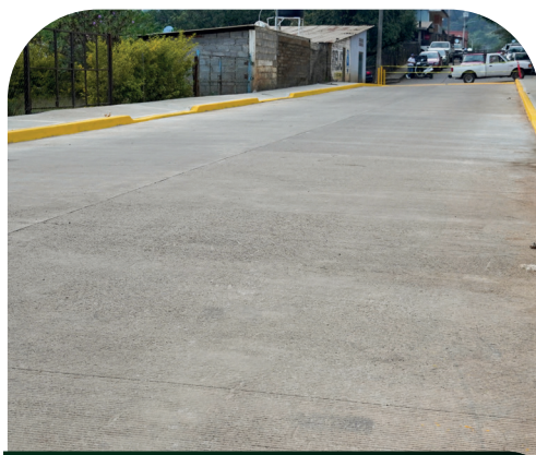
Construcción de pavimentación en Uringuitiro, calle Benito Juárez. Esta obra benefició a 764 personas y tuvo una inversión de $1,443,237.42
