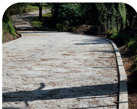
Construcción de pavimentación en Zirimondiro, acceso a la zona sur de la localidad. Benefició a 1,186 personas, con una inversión de $1,084,712.54
